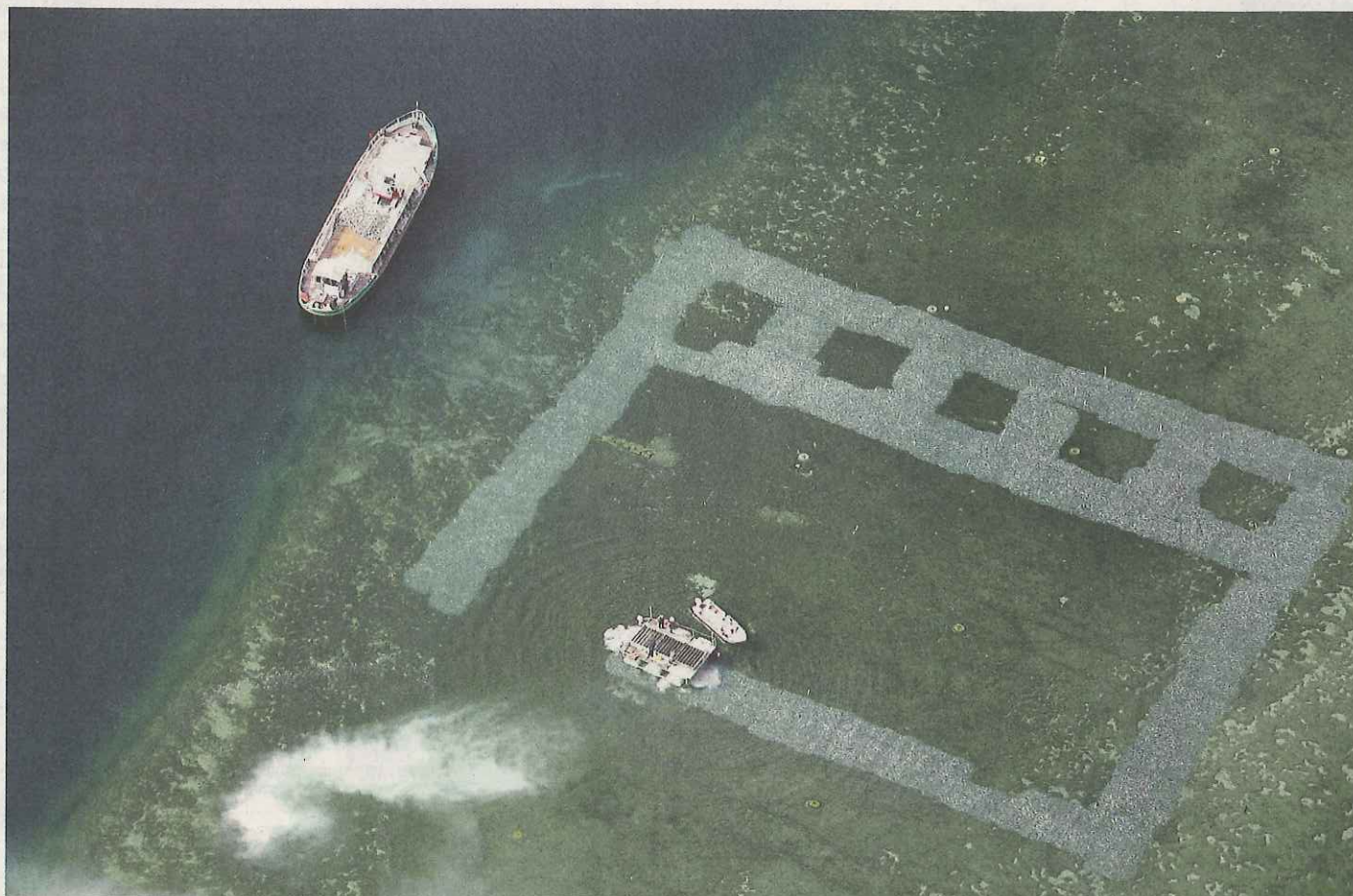
Steinzeitsiedlung sichern: Am Überlingersee wird Kies in Waben ausgebracht, in denen sich Sediment als zusätzlicher Schutz abgelagert.
